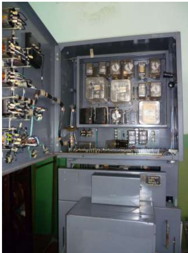
Рис.13. Зовнішній вигляд лабораторного стенду №8.2 з демонстративними матеріалами для вивчення конструкції та принципів роботи виміривальних трансформаторів напруги 6-110 кВ
