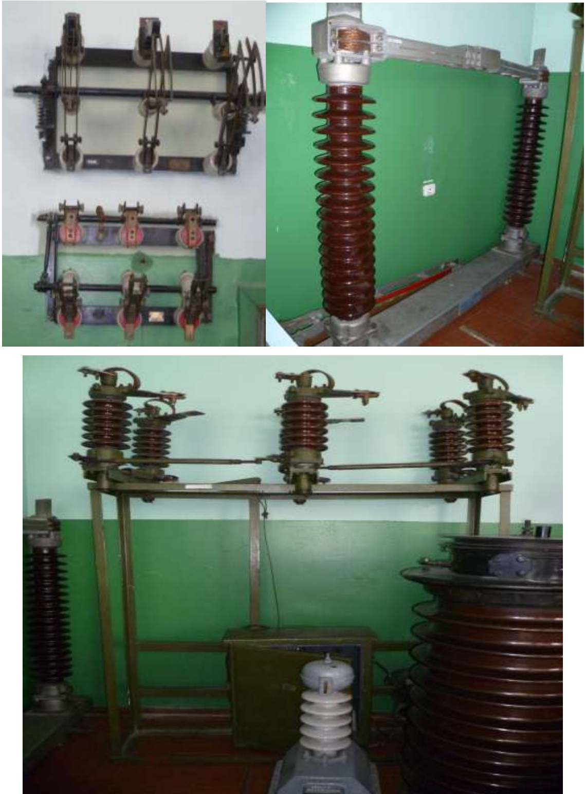
Рис.10. Зовнішній вигляд лабораторного стенду №6 з демонстративними матеріалами для вивчення конструкції роз'єднувачів, вимикачів навантаження, віддільників і короткозамикачів
